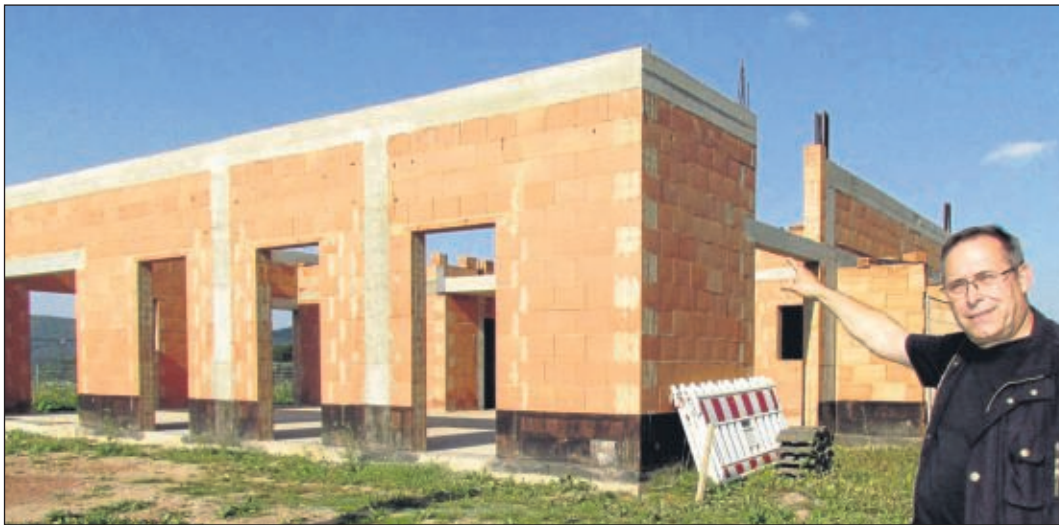
Erdgeschoss im Rohbau: Am Grenzmuseum Sickenberg hat sich schon einiges getan, das künftige Eichsfeldcenter ist schon zu erkennen, hier gezeigt von Projektleiter und Architekt Stefan Heuckeroth-Hartmann vom Arbeitskreis Grenzinformation.
